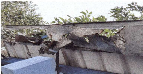
Foto1: Canales de bajada de agua
